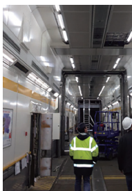
Eclairage de RACKS (4 - 6 mètres) LIMA ou BOGOTA Puissance : 45W - 53W Lumens : 7200 - 8480 lm
